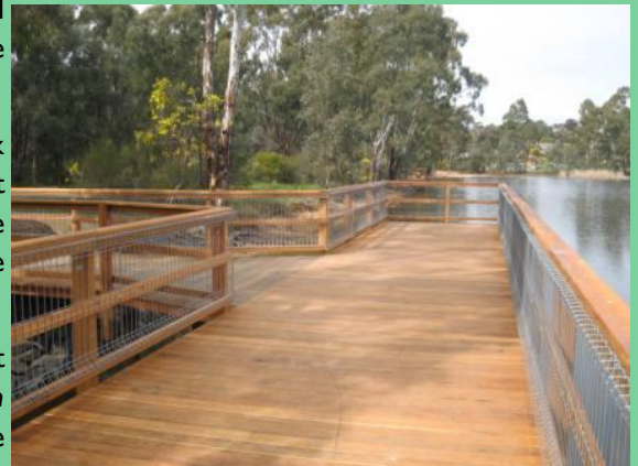
'T Shaped' Jetty
